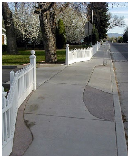
ADA sidewalk retrofit
