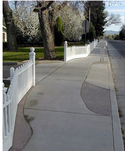
ADA sidewalk retrofit
