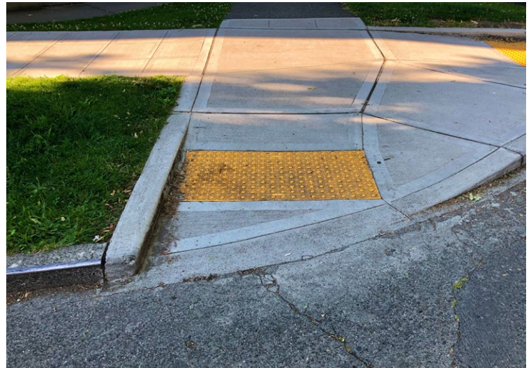
ADA curb ramps
